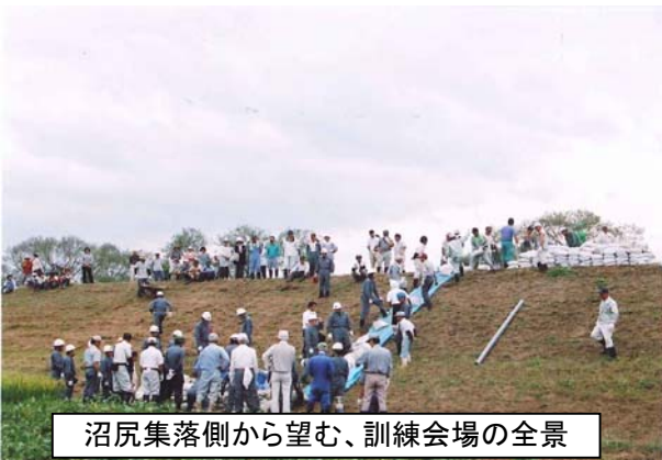
漏水の噴出口を中心に土のうを積み、水の噴出を止める「釜段工」の水防訓練
