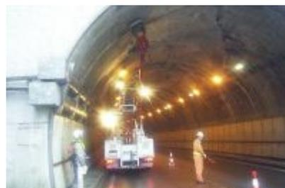
写真2-2 トンネル点検状況
