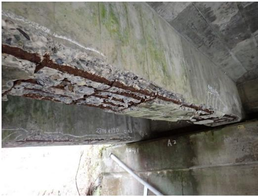
【損傷】剥離・鉄筋露出
