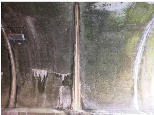
【損傷】漏水
