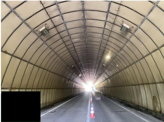
【損傷】面導水工の腐食、漏水
