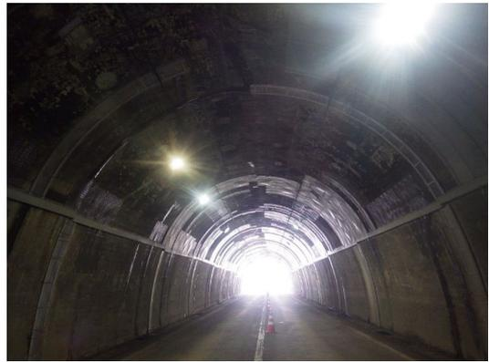
【対策】内装板撤去・漏水対策工
