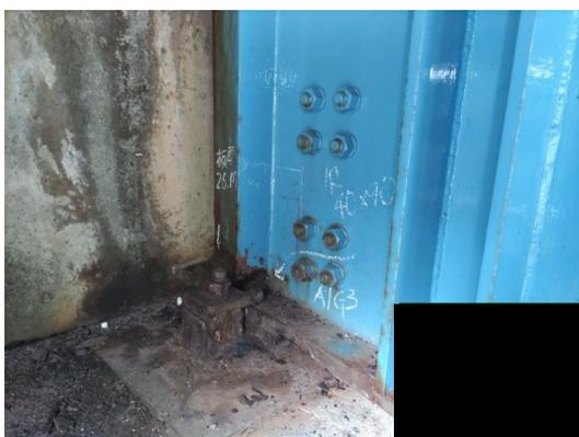
【損傷】主桁腐食
