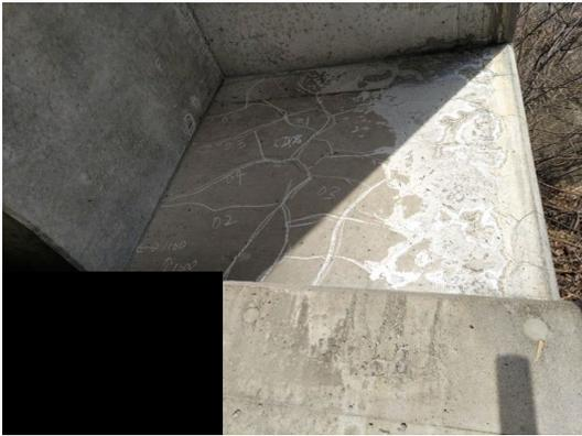
【損傷】ひびわれ
