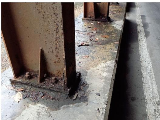
【損傷】支承部の腐食
