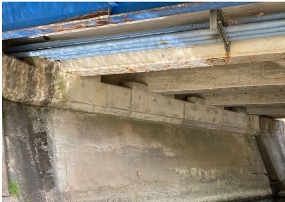
【損傷】A1 橋台コンクリートのひび割れ
