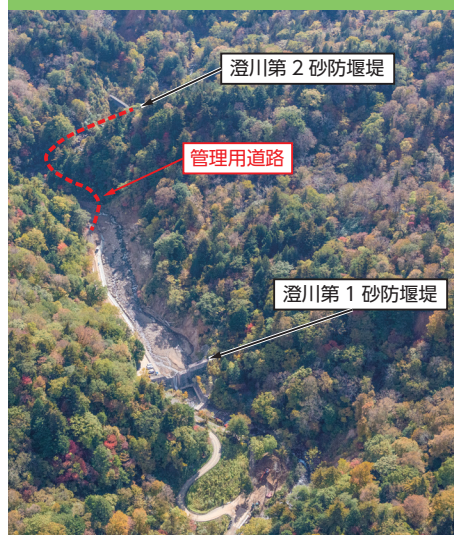
③澄川第2砂防堰堤 R7実施内容：管理用道路工
