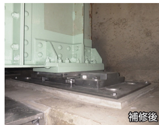
橋梁補修(主桁補修工、支取替工)
