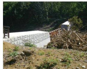
土石流発生後（H25年9月17日）
