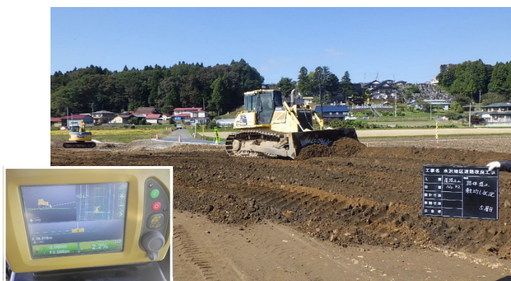
ICT建設機械による盛土施工
