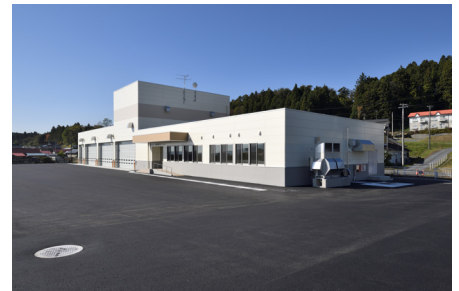
防災除雪ステーション(R5.11完成)
