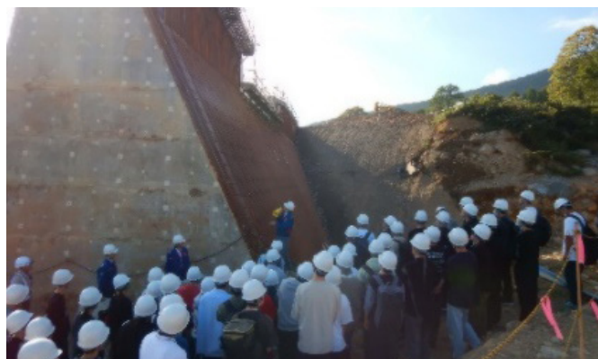
うさぎ平西沢砂防堰堤
