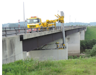
橋梁定期点検
