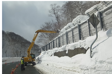
せき処理 雪底処理
