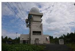
レーダー雨量観測所
