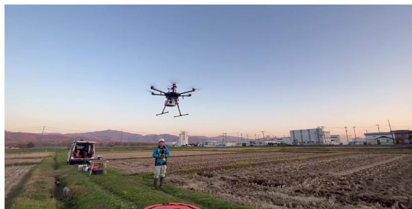
UAVによる路線測量(盛岡南道路)
