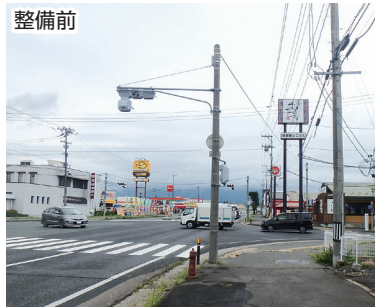
整備前 盛岡市津志田(国道46号)
