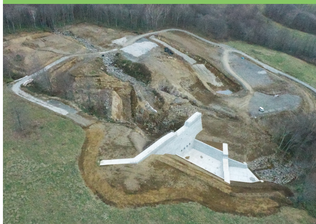
①うさぎ平西沢砂防堰堤 R7実施内容：砂防堰堤工
