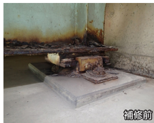
橋梁補修(主桁補修工、支取替工)
