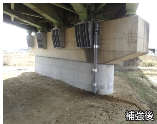
橋梁耐震補強 (横変位拘束構造)
