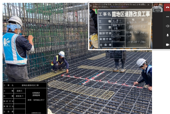
遠隔臨場による鉄筋出来形測定
