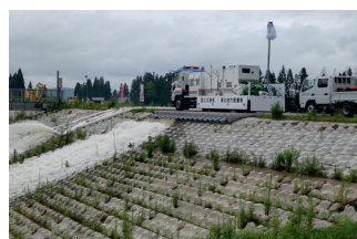
災害対策機械 排水ポンプ車による内水排除 (令和6年7月豪雨 秋田県大仙市)
