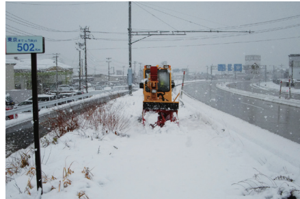
歩道除雪(機械)
