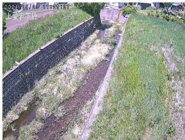
河川監視カメラ設置
