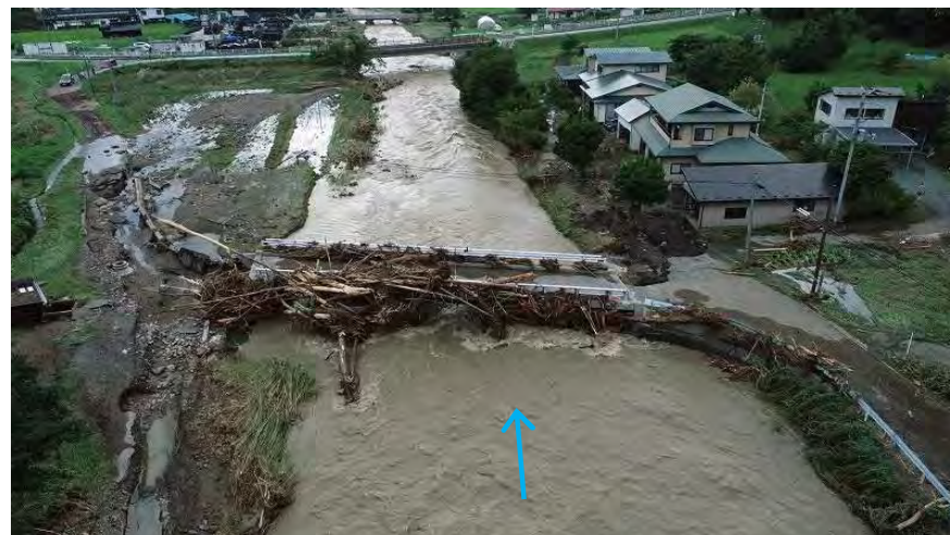
どめき 百目木橋付近(R6.8.29撮影)【18ブロック】
