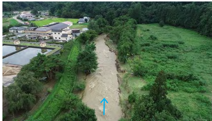
米内浄水場付近(R6.8.29撮影)【16ブロック】
