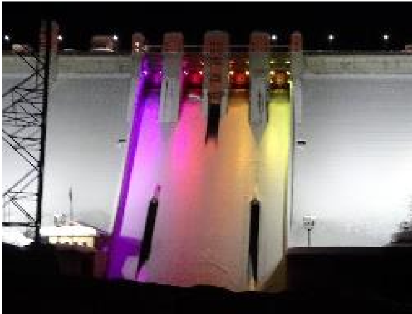
▲試験点灯状況
