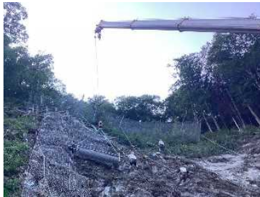
▲ 落石防止網施工状況
