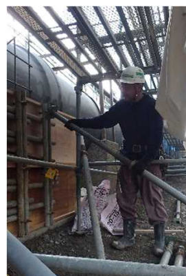
型枠を固定する作業を見せられました。
