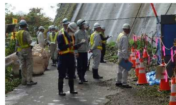
▲工事現場点検の様子
