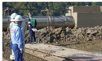
▲工事現場点検の様子
