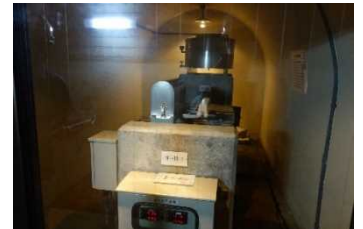
「プラムライン」 堤体にひずみがないかを確認します。
