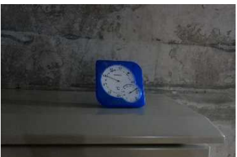
堤体内の温度は一定で約10℃。 とても涼しく感じます。
