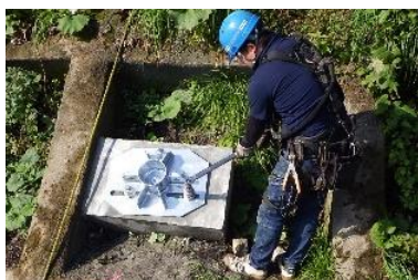
基部ナット締付状況
