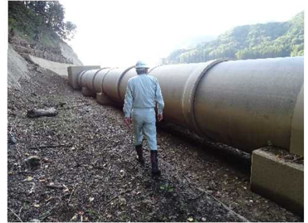
▲清水バイパス点検の様子
