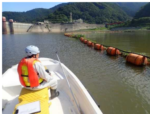
網場(あば)というダムに流れてきたゴミなどがゲートなどに引っかからないように止める施設を点検中。
