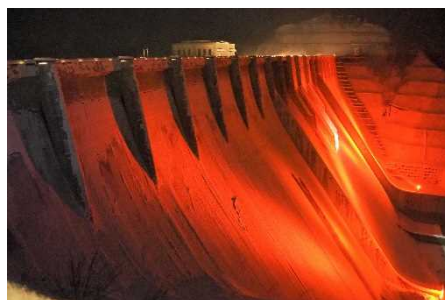
【津軽ダム】5分毎7パターンのカラーチェンジ
