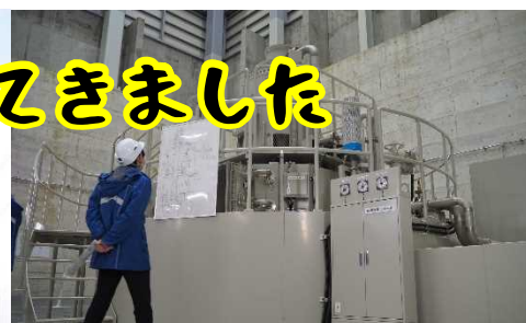
▲発電機全体、この中に巨大な電磁石とコイルが入っています
