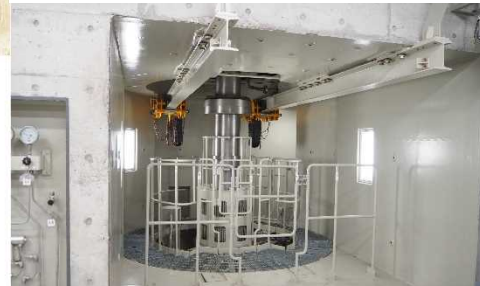
▲水車の真上、回転軸がまわっている様子を見ることが出来ます。すごい音がしています！
