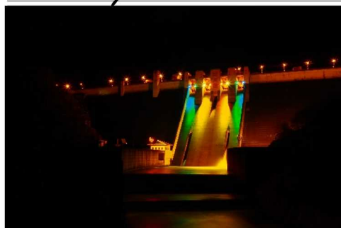
▲コンジットゲート放流と浅瀬石川ダム
