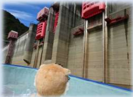
↑ダム本体やゲート設備に異常なし！！
