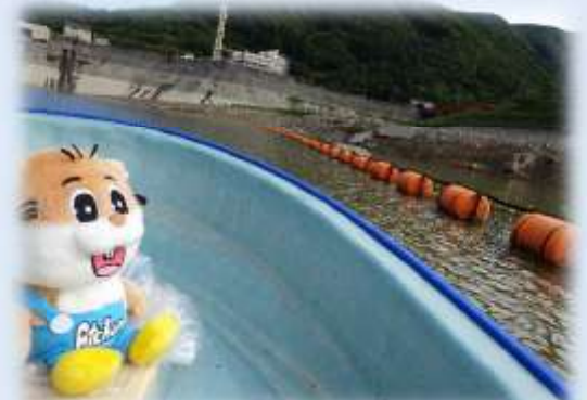
↑網場(あば)という流木止め設備を点検！ ロープが切れていないか見ているよ～。 8月の出水で大量の流木を捕捉し大活躍！
