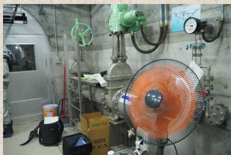
コロナ禍前の見学会では、こちらでコンジットゲートの説明をしていました
