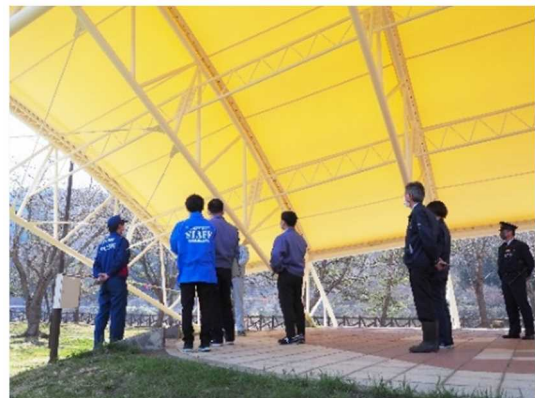
▲虹の湖公園ふれあいの広場(黒石市)での点検の様子
