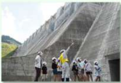
▲ダムの内部を通過して下流に。大きさを実感
