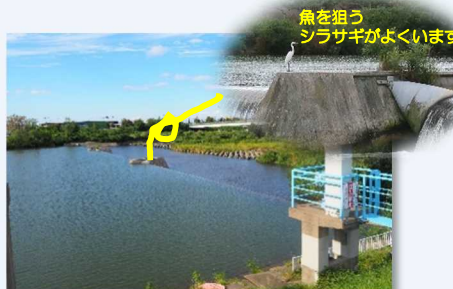
▲弘前市の岩木菫橋上流のゴム引布製起伏堰。 取水口はこの直上流右岸にあります
