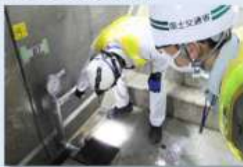
▲木戸ヶ沢貯水池保全施設巡視の様子
