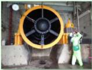
③導水管の分岐管である放流バルブを外から見た様子
