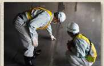
▲【放流管内部にて】溶接部に異常が無いかが指差し確認
