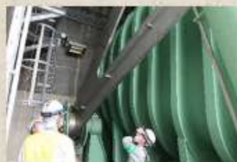
▲【放流管の横】放流管の外側や脚柱の状態もチェック！脚柱は55mmと薄い！
