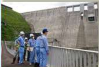
▲維持工事業者との点検 (白神が故郷橋パーク)
