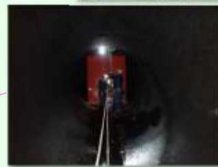
②導水管入り口。勾配25度の管内をこのロープを伝い後ろ向きに進み、約100mの管内部に錆や傷など損傷がないか点検を行います
