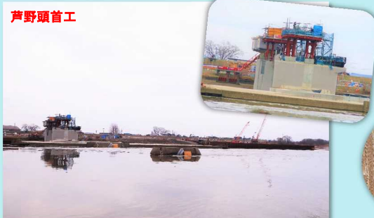
②芦野頭首工に到着。岩木川河口から11kmの所にあります。令和3年3月現在は工事中。工事現場を見るのも楽しいね! 完成が楽しみ♪
