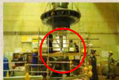
⑤水車部分の組み立て作業。慎重に位置を確認して行われていました。
