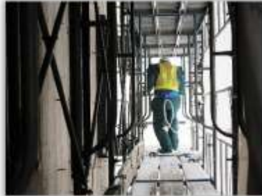
◆作業足場も実際に歩いて通路の安全が確保されているかなどをチェック！
