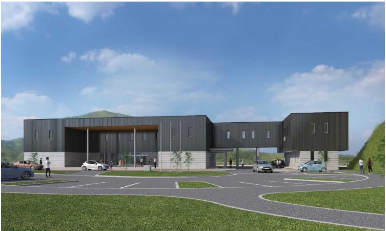
▲完成予想図(令和3年度の完成を目指し、現在も工事が進んでいます)
