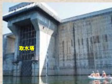
▲ダム堤体の破損が無いか、量水標が汚れていないかななどを目視で確認。こんなに間近まで接近して点検しています！！
