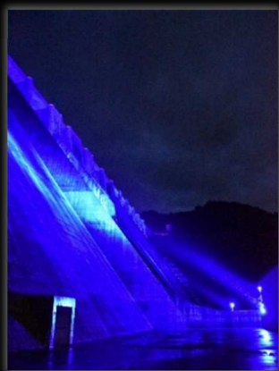
▲2日夜の津軽ダム、雨に反射するブルーライトが幻想的な空間を映し出しました。
