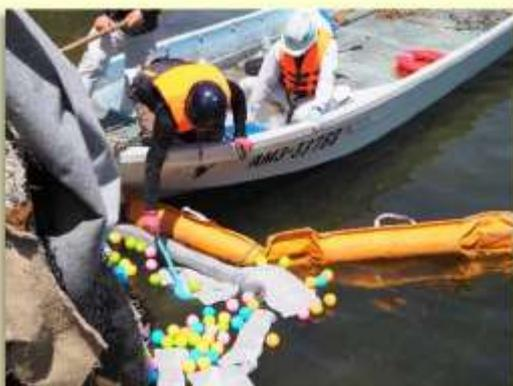
▲活性炭入りのオイル吸着マットで拡散を最小限に食い止め、柄杓などを使い丁寧に油膜を回収します。
