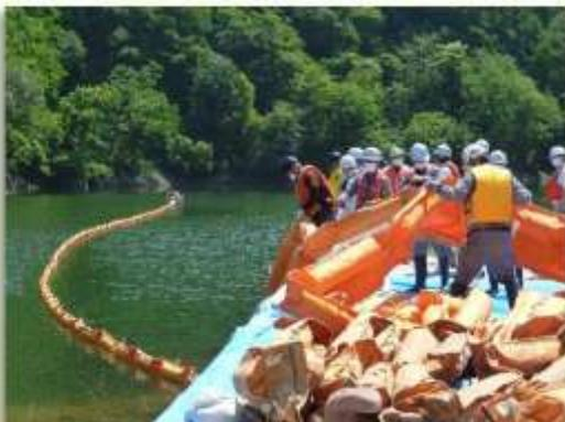
▲実際に対岸までオイルフェンスを設置しました。引かずと損傷してしまうので取り扱いも慎重です。
