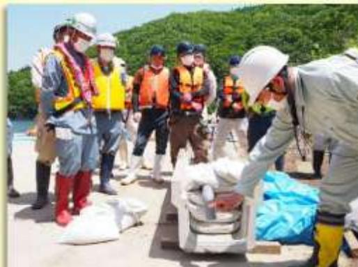
▲水路や側溝などで油の流下拡散を防止する【土のう積工法】はよく用いられる方法です。
