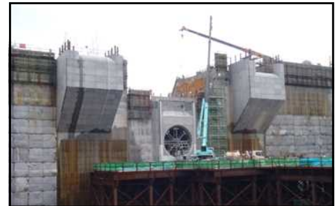
ダム本体と放流設備工との同時施工
