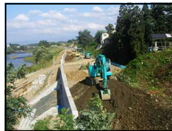
【下流工事用道路の工事状況】
