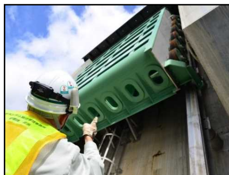
放流設備点検状況
