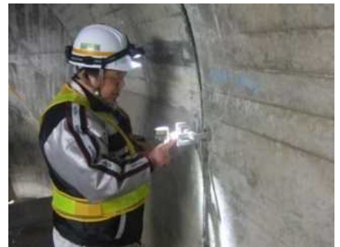
■ 堤体監査廊内の巡視
