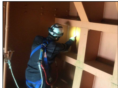
ゲート設備点検状況
