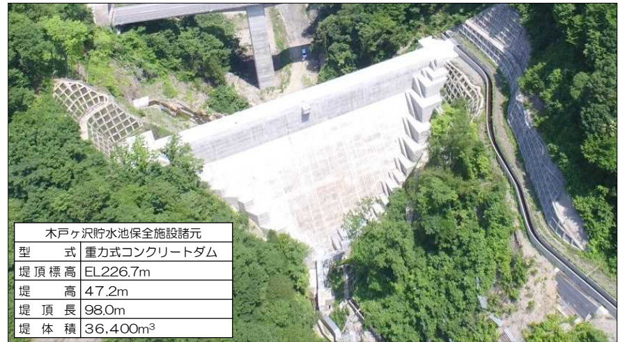
■ 平成27年6月撮影（かん止堤側より）
