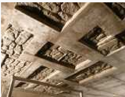
■ コウモリがつかまるボックス天井の凸凹
