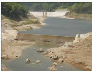
■ 1号水質保全施設
