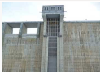
■ 選択取水設備
