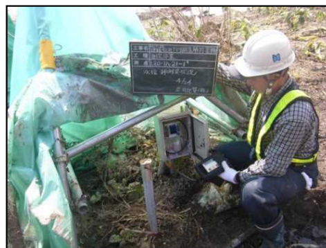
地すべり観測状況
