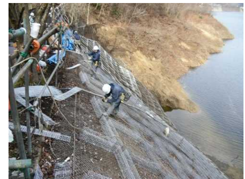
■ 法面補修工事施工状況
