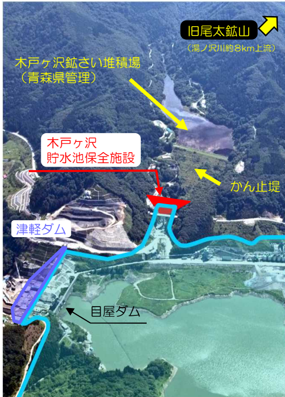
■ 木戸ヶ沢堆積場（既設）と木戸ヶ沢貯水池保全施設
