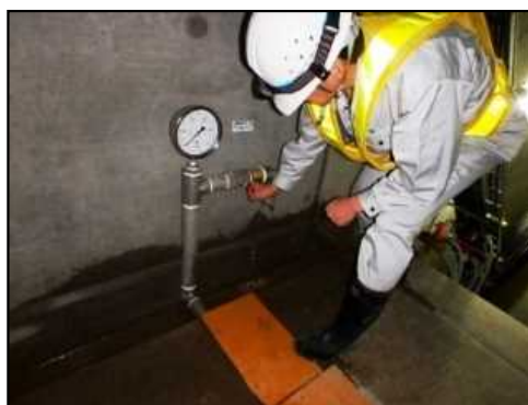
■ 揚圧力の計測（基礎排水孔）
