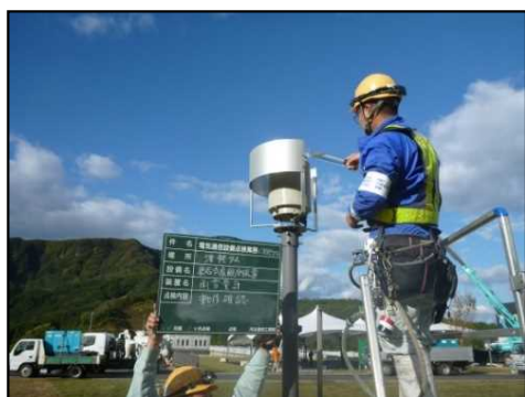
雨量計点検状況
