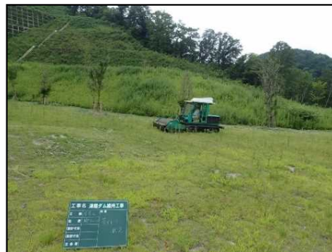
除草作業状況
