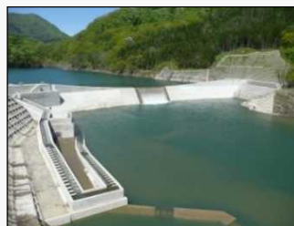
■ 2号水質保全施設
