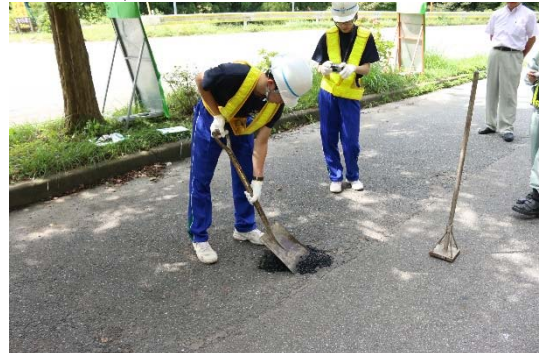
舗装の応急補修作業を体験（※）
