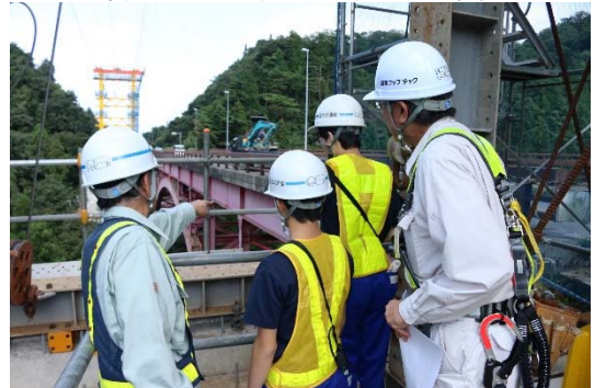
常磐バイパス菅波大橋の現場見学
