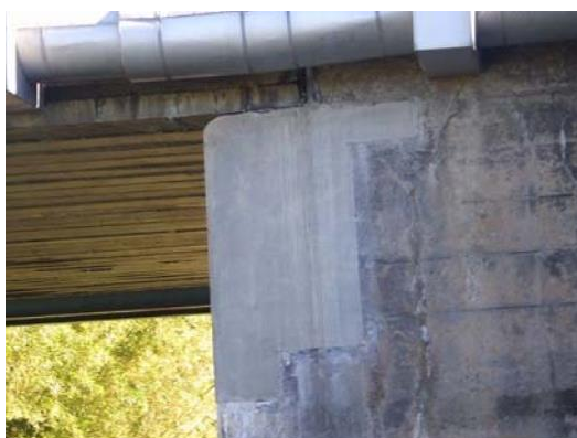
【対策】 断面修復工
