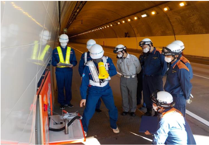
消火栓の操作方法を確認しています。
