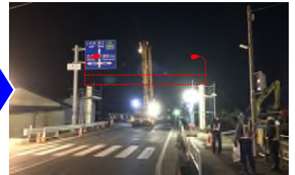
▲全て撤去(橋脚のみ！)
