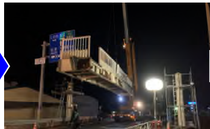
▲橋桁部を撤去
