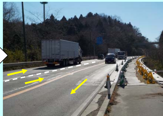
▲車線開放後の状況
