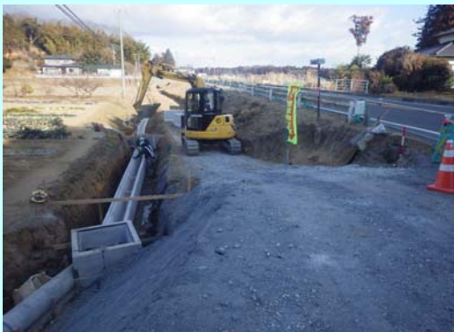
▲国道6号の下り線側に土を盛り始めます。
