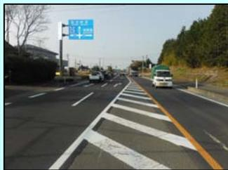
経年劣化により、元々舗装に傷みが確認されていましたが、復興工事等による大型車の増加により、舗装劣化が加速していました。その為、既設の舗装を撤去し、再度舗装を行い、「ひび割れ」・「わだち」の無い、快適に走行できる道路に復旧しました。
