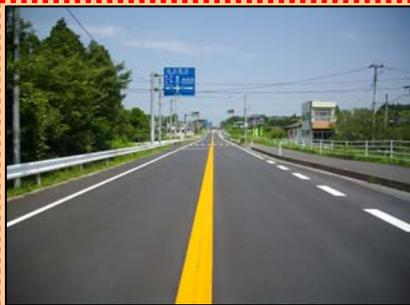
善光寺・石上地区以上に舗装の劣化が進んでたいたほか、舗装下の地盤の緩みが確認されたため、舗装版を完全に除去し、地盤の再構築を行った上で、舗装を補修しました。
