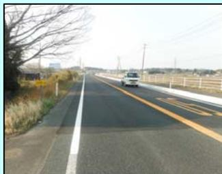
震災により地下横断構造物周辺に段差が発生していましたが、その後も段差が拡大し、円滑な交通に支障をきたしている状況であったため、段差擦り付けを行い、快適に走行できる道路に復旧しました。
