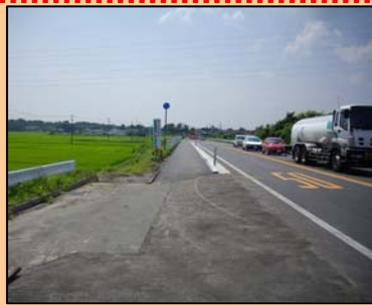
震災により歩道も沈下や段差発生などの被害を受けており、舗装の亀裂や、舗装沈下による水たまりが発生していたため、今回の車道の工事に併せて補修し、歩行者も快適に利用できる歩道に復旧しました。
