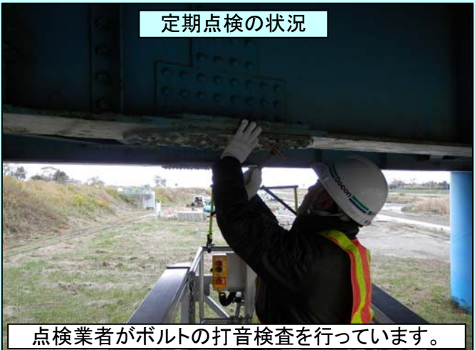
橋梁点検車を使い、接近して点検を行います。
