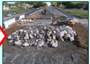
新しい長原橋を作るため、橋本体の施工に着手。
