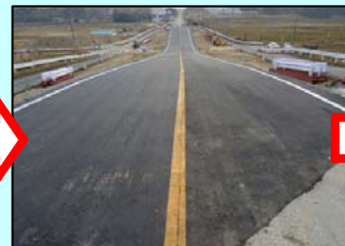
橋を撤去し、本線を応急的に舗装後、仮設道路として交通の確保を図った。
