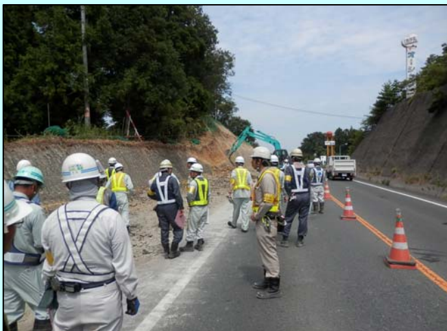
工事施工中の現場を参加者全員でパトロール
