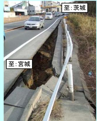
この箇所は、震災直後は片側交互通行とし、4月下旬にいったん応急復旧工事を行って対面通行を確保しました。今回、抜本的に補修するため、一度車道を1車線分歩道側に切り回して、緩んだ地盤を掘削し、再度盛り直す復旧工事を行ったものです。
