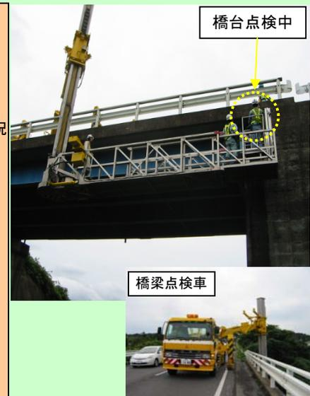
点検は、目視やハンマーによる打音調査を行い、コンクリートの亀裂や橋桁の錆び、伸縮装置からの漏水状況など普段点検できない箇所を詳細に調査します。
