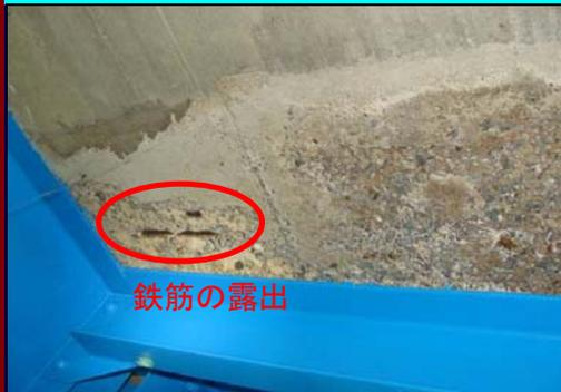
床版(路面)裏の鉄筋が露出しています。原因としては、橋梁継ぎ目からの漏水による鉄筋のサビ→鉄筋膨張→コンクリート剥がれが考えられます。
