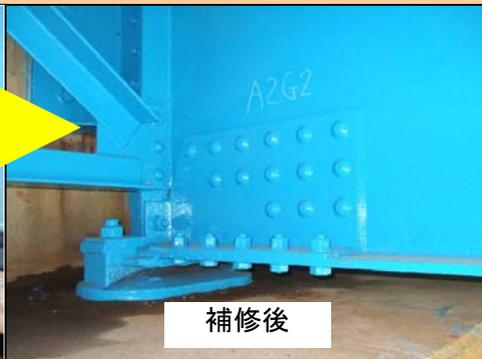
橋梁継ぎ目からの漏水等により橋桁が腐食し橋桁沈下の恐れがあることから、腐食部分を当て板で修理し再塗装を行ないました。(この橋は、完成してから44年経っています)
