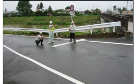
百槻地内点検の様子（急勾配を確認中）
