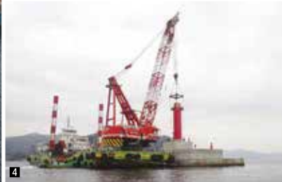
1 ケーン船繋付の様子 2 釜石港全景 3 湾口防波堤(左が北堤、右が南堤) 4 赤灯台設置の様子
