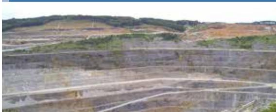
露天掘りの石灰石鉱山で、正式名称は八戸石灰鉱山。現在の最深部は海拔マイナス170m、国内で最も空が遠い場所と言われています。採掘現場には入れませんが、鉱山展望台からその圧倒的なスケールを感じることが出来ます。鉱山と八戸港の専用埠頭及び八戸セメント(株)を総延長約10キロの地下ベルトコンベアで結び、石灰石を運んでいます。
