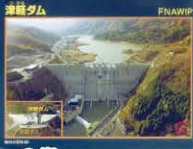
つぐとぐの 津軽ダム (建設中)
