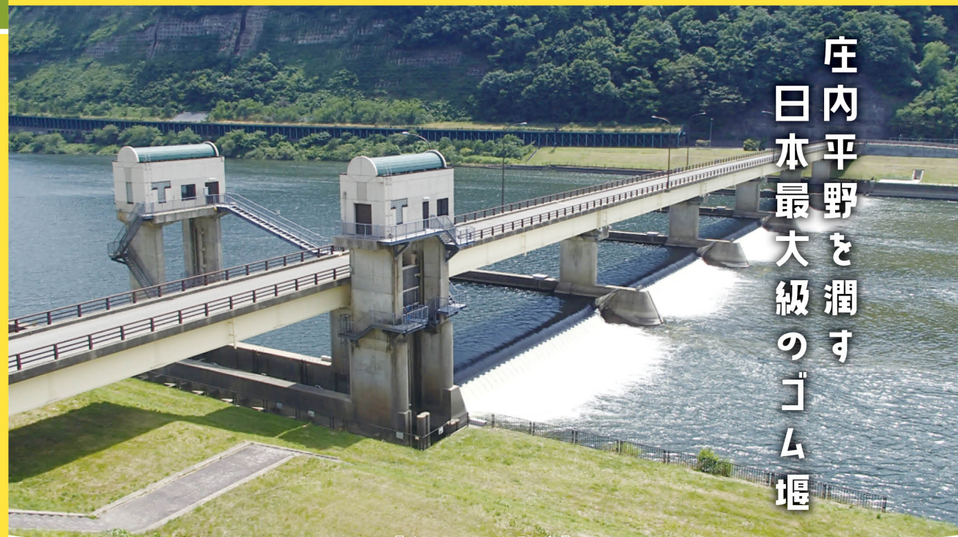
最上川さみだれ大堰の全景
