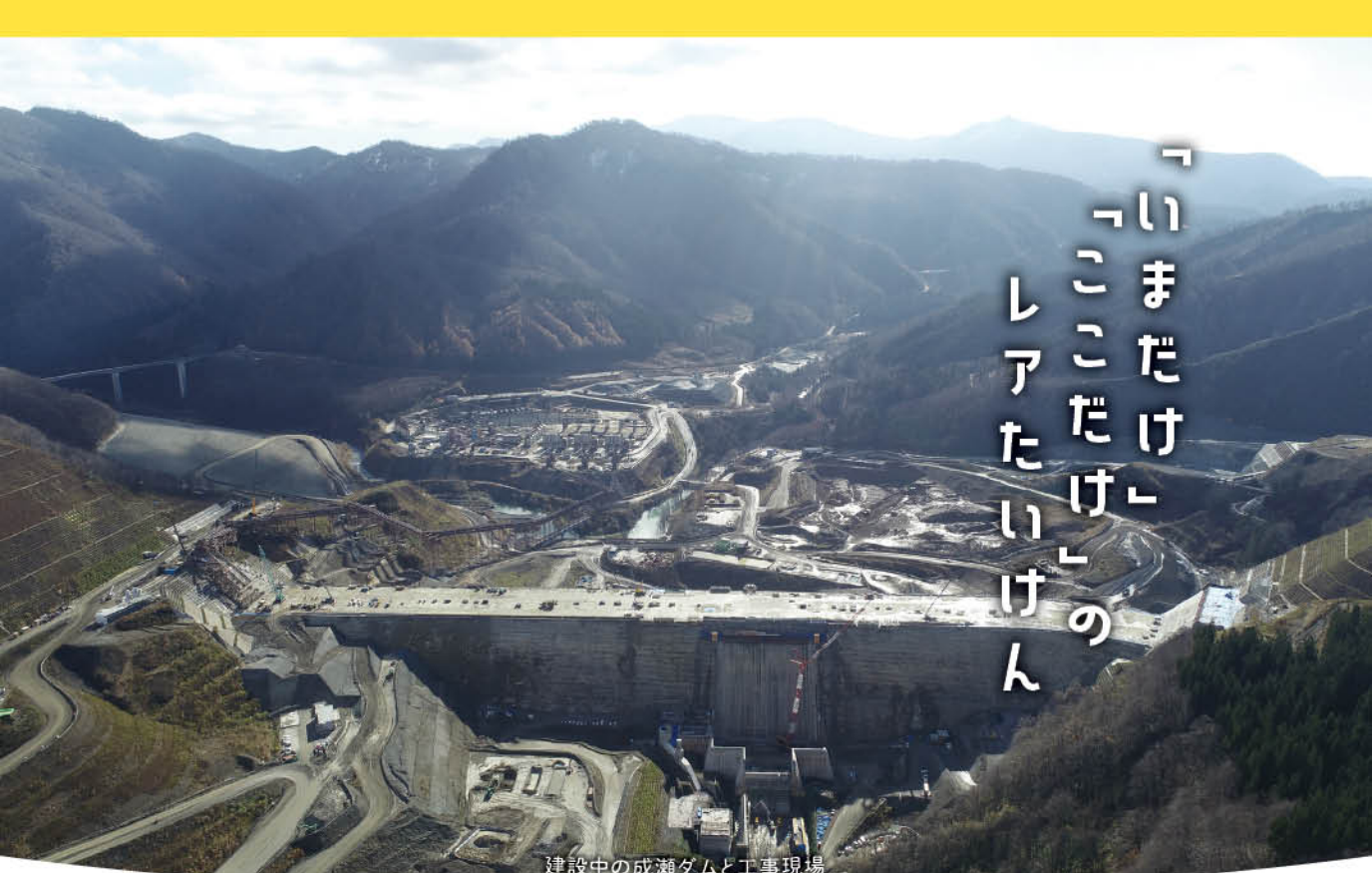
建設中の成瀬ダムと工事現場
